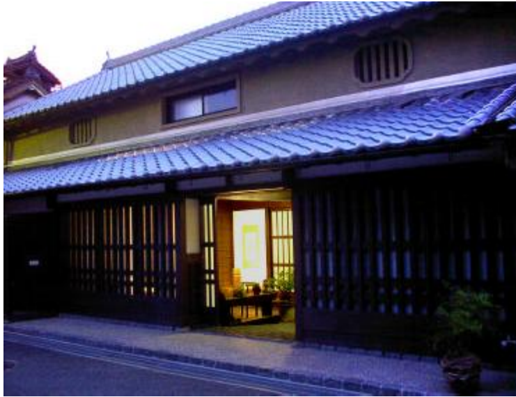
伊勢街道に面する正面 無双窓と煙だしがある
