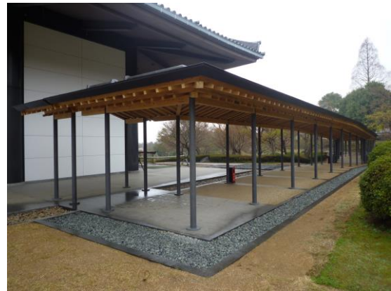
新公会堂・シルクロード交流館渡り廊下
