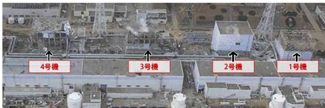
図2 地震及び津波発生後の福島第一原子力発電所（1～4号機）の外観。
